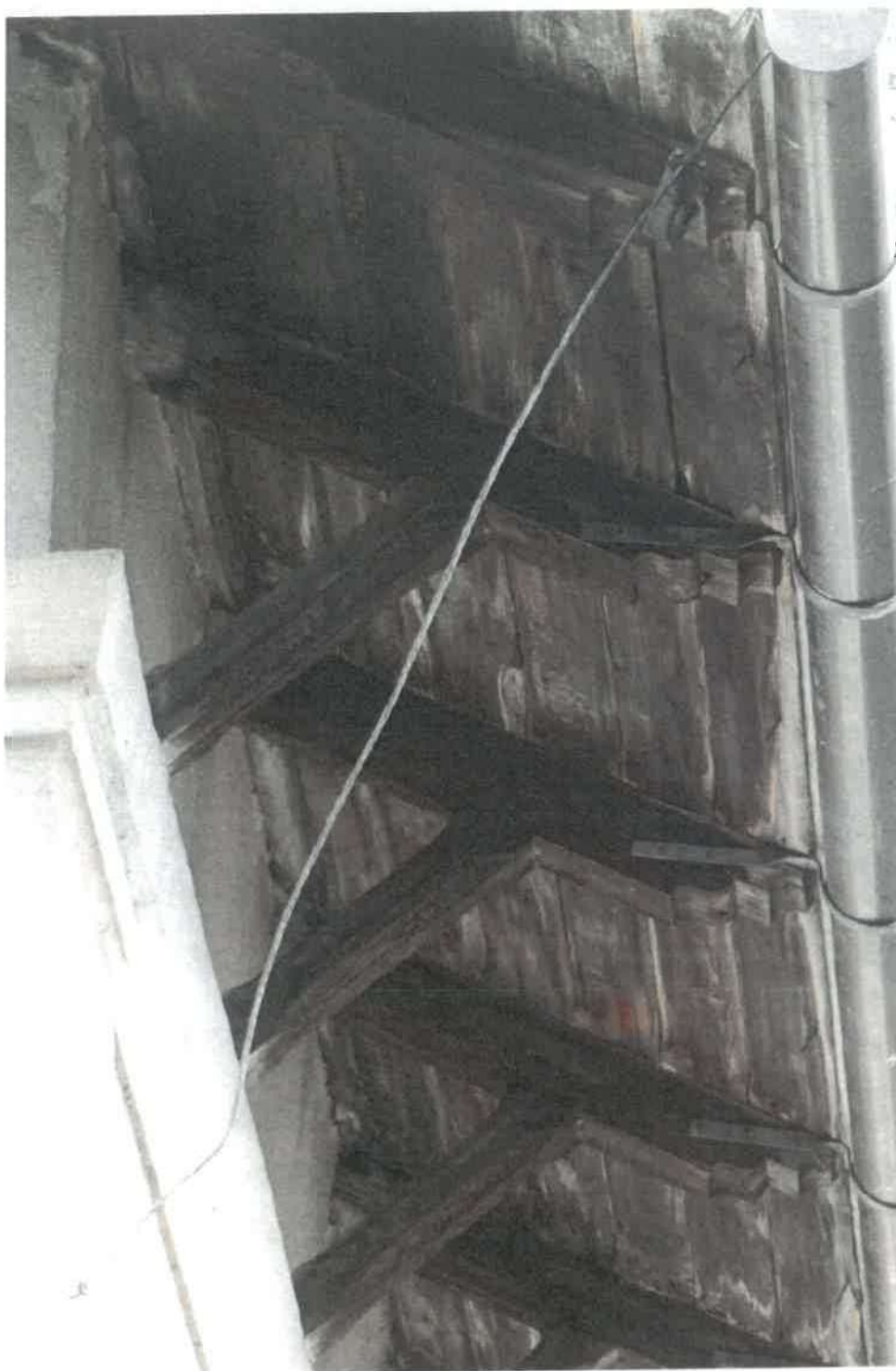
Zdj. 8 Widok zdobień końcówek krokwi od strony południowej oraz stanu zachowania podsiębitki, Przyszowa, fot. K. Kot Poszycie dachowe to dachówka ceramiczna żłobkowa(?) wraz z ceramicznymi gąsiorami.
