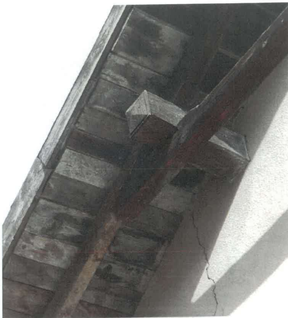
Zdj. 7 Widok pojedynczego zdobienia końcówki płatwi od strony zachodniej oraz stanu zachowania podsiębitki, Przyszowa, fot. K. Kot
