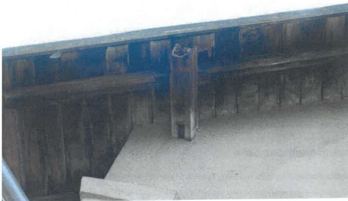
Zdj. 11 Widok stanu zachowania końcówki płatwi oraz podsiębitki od strony wschodniej, Przyszowa 2023, fot. K.Kot
