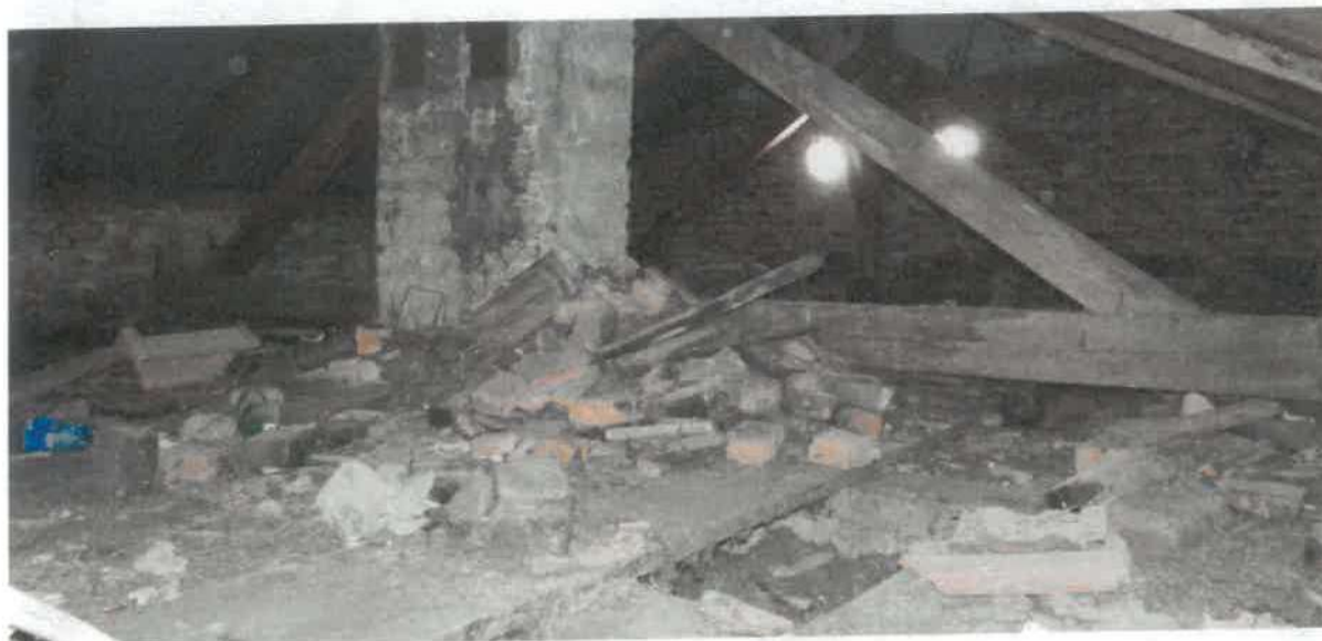
Zdj. 10 Widok zagruzowania kondygnacji strychu, Przyszowa 2023, fot. K.Kot
