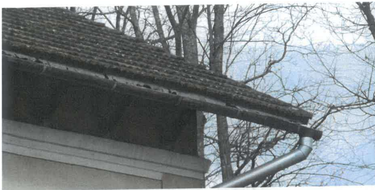
Zdj. 13 Widok stanu zachowania wtórnej membrany oraz systemu odprowadzającego wodę opadową, Przyszowa 2023, fot. K.Kot
